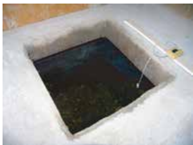
水深約400mmの水を満した床下点検口
