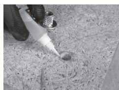
ベースパネル裏面から穴の周囲に瞬間接着剤を塗布
