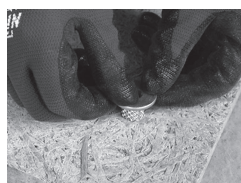
ベースパネル裏面からナットを垂直に仮挿入
